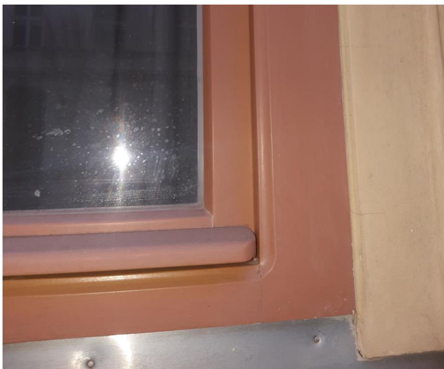
Obr. 2 – Vzor frézování rámu
